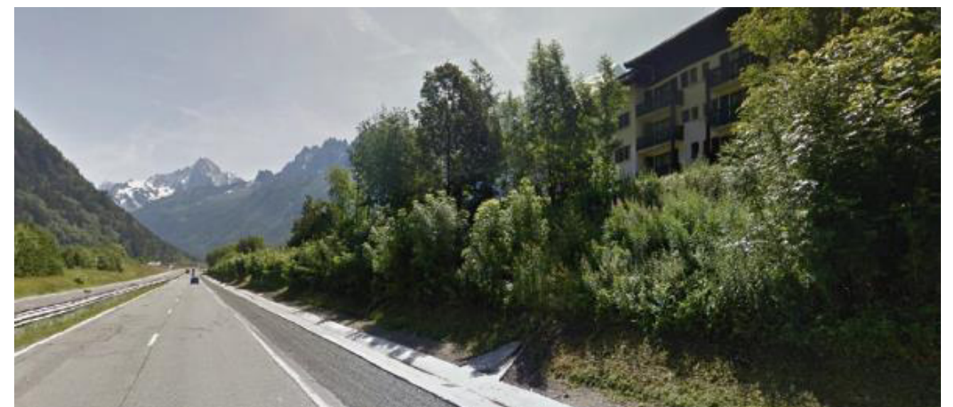
Figure 6 : RN205 après la sortie de la rue de l'Aiguille Verte
