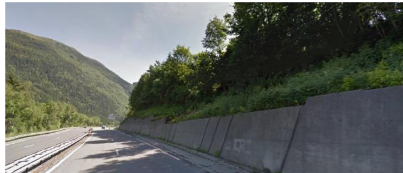
Figure 40 : RN205 après le franchissement de l'Arve
