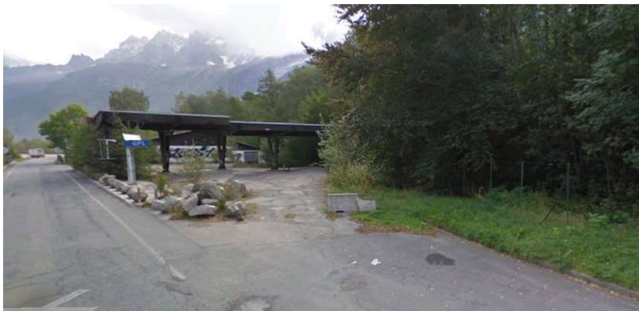
Figure 4 : Emprise de l'ancienne station-service
