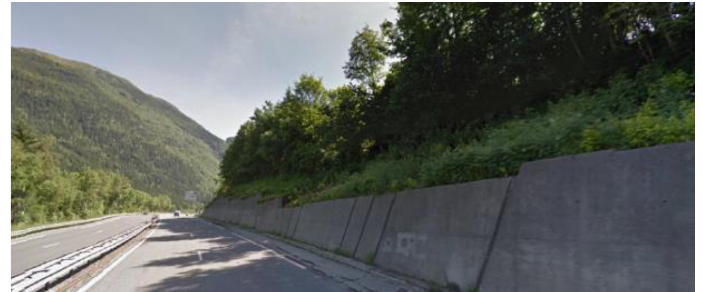
Figure 5 : RN205 après le franchissement de l'Arve
