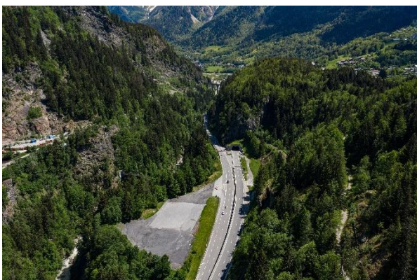
Tunnel des Chavants©ATMB
