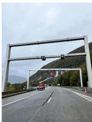
Tunnel du Vuache©ATMB
